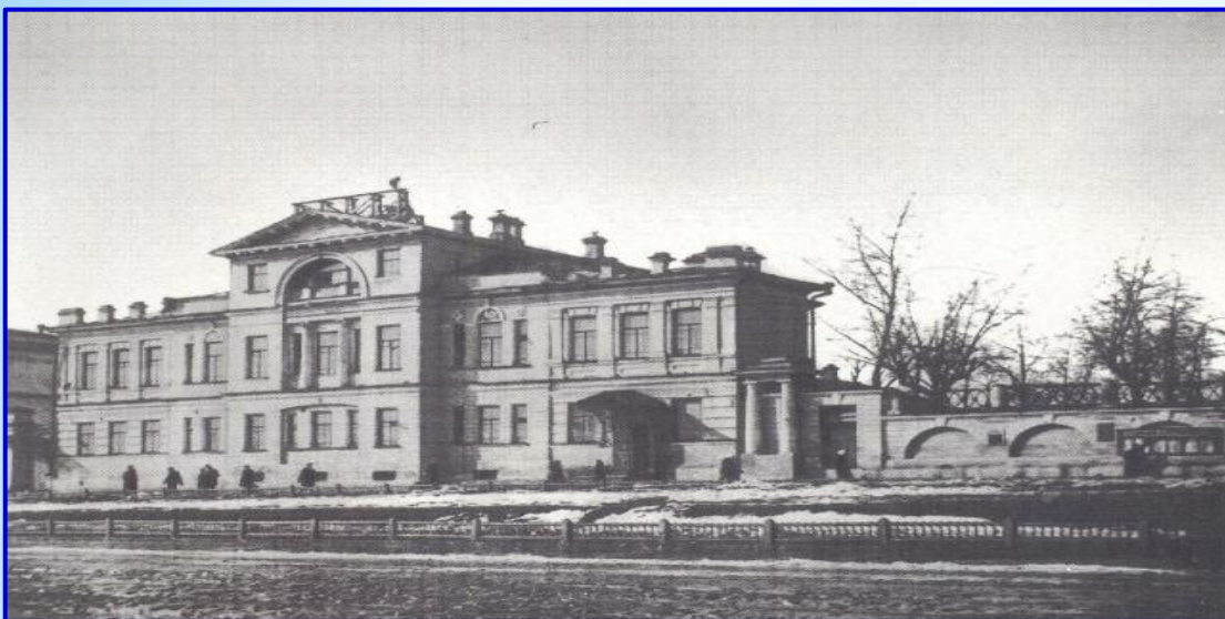
Аптека Горного управления на Екатерининской площади (площадь Труда). Фотография 1947 года.
